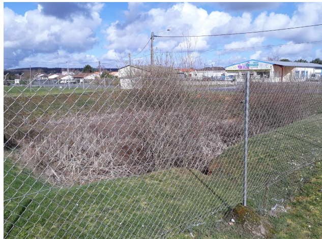
Figure 4 : Photo du bassin d'orage existant
